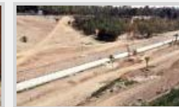
Obras en la ladera del Vinalopó a su paso por Elch
